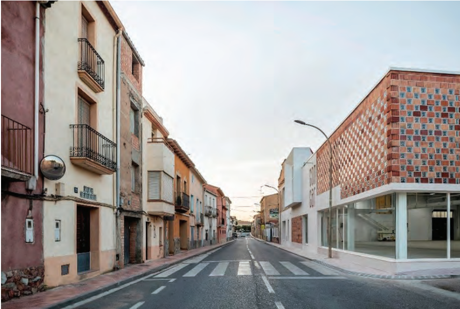
NUA Architectures, Talleres Gon-Gar en Benissanet (Tarragona), 2018
