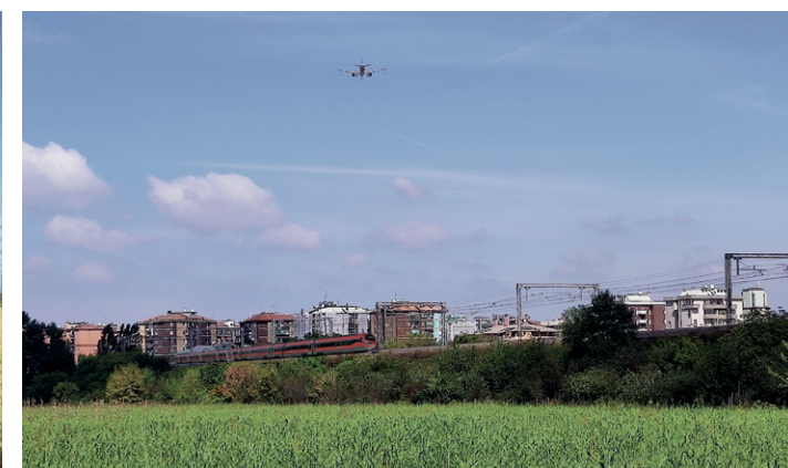
Fig. 6. Abadía de Viboldone (San Giuliano Milanese). Contexto ambiental de inserción en el área del Parco Agricolo Sud Milano, caracterizado por la presencia de un sistema de canalización desarrollado en diferentes épocas y por una sucesión de paisajes distintos formados por la vegetación ribereña, los cultivos intercalados con torres telefónicas y los elementos impactantes de delimitación del desarrollo urbano, como el ferrocarril y las rutas aéreas. Fotografías de la autora
